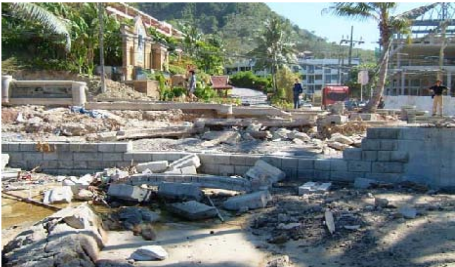
Patong A地点；護岸ブロック海側へ破壊
