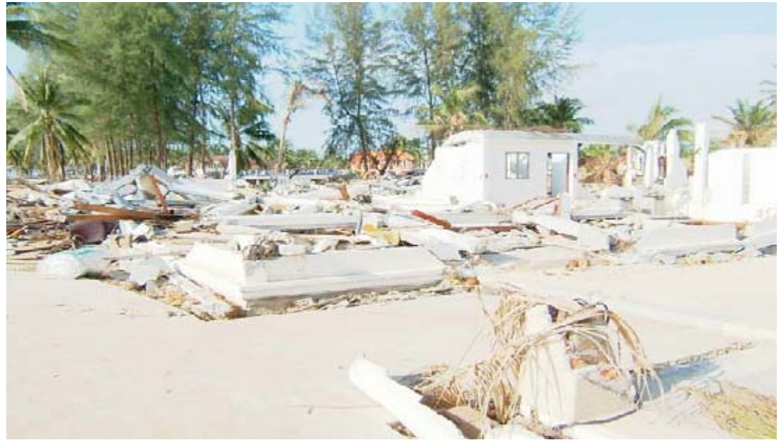
KhaoLak F地点；浜崖～30m間全壊，30m以遠は柱有
