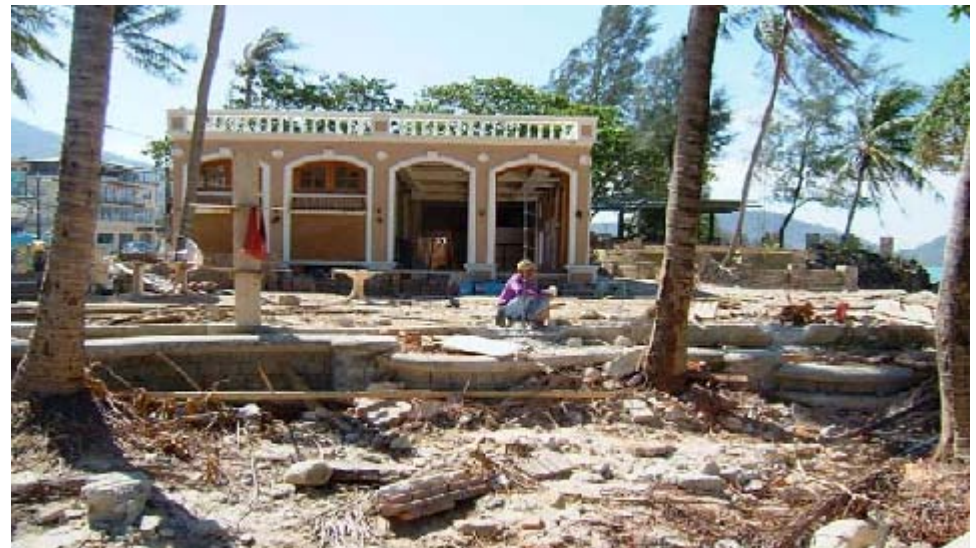
Patong A地点；柱無傷，海側窓と木製扉破損
